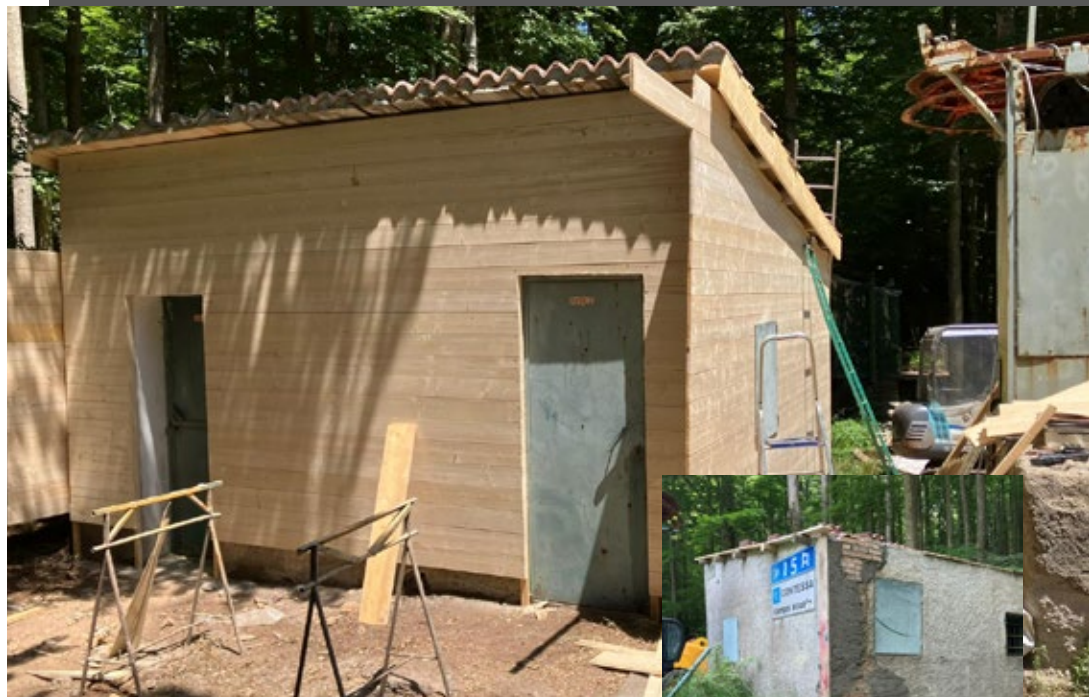
Recupero vecchia biglietteria e partenza sciovia
